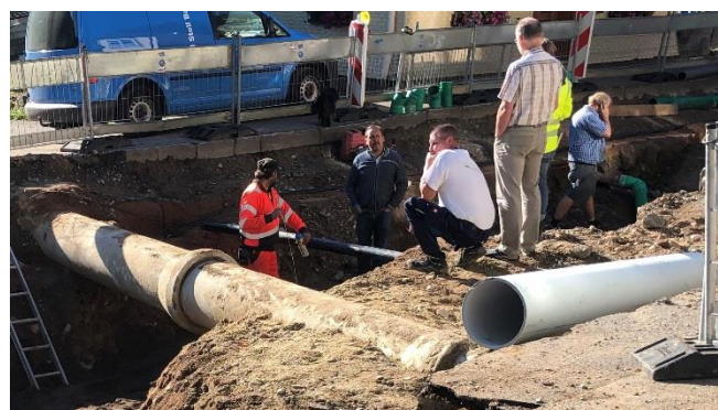
03.09.2019: Sanierung der Wehratalstraße in Arbeit
