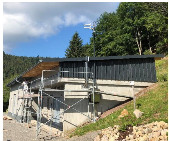
16.07.2019: Erweiterung Hochbehälter Kälberweid
