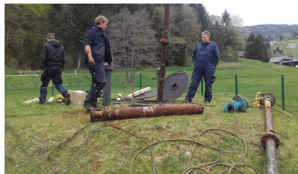
29.04.2019: Der Tiefbrunnen wird saniert
