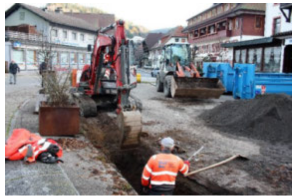
Fernwärmeleitungen werden verlegt
