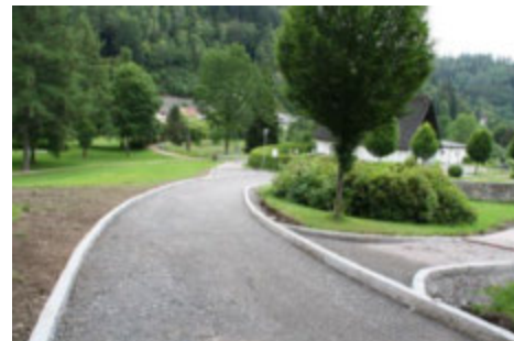
22.06.20: Friedhofsplatz wird fertiggestellt
