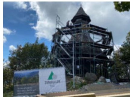
03.09.20: Sanierungsarbeiten am Hochkopfturm beginnen
