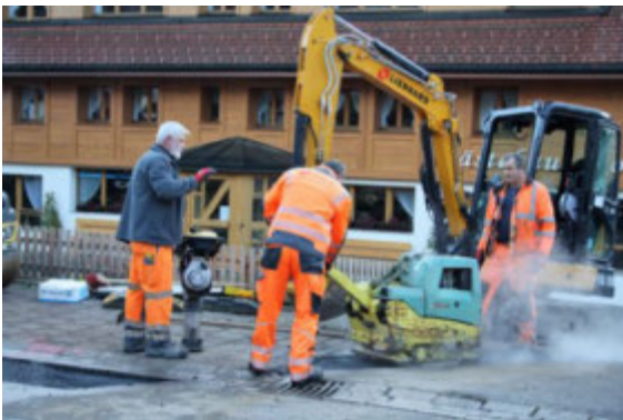
10.11.20: Viele Baustellen im Ort, hier Breitband-Ausbau
