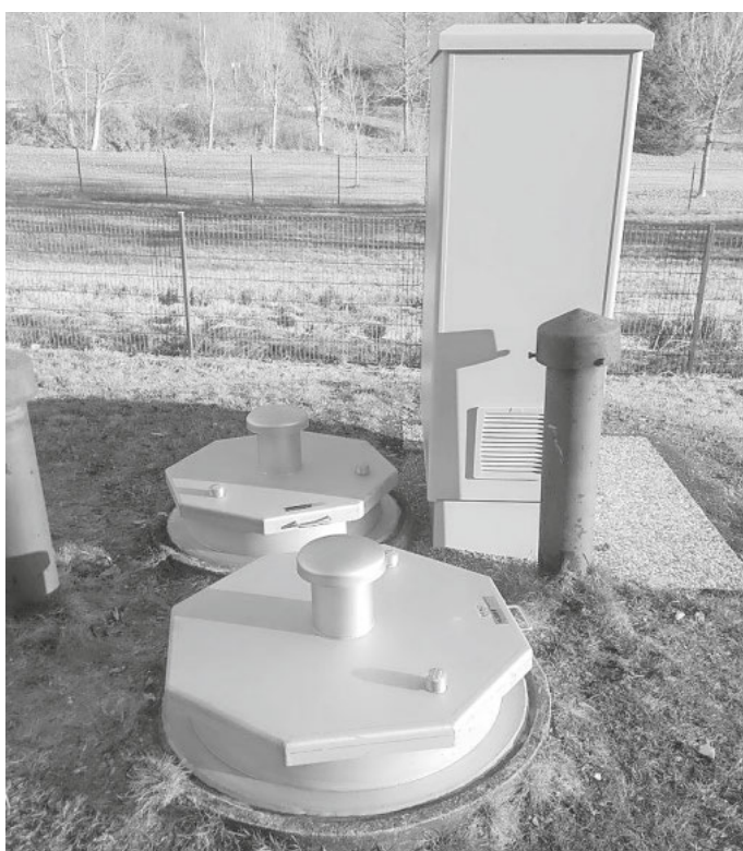
Die Schachtabdeckungen und die Einstiegsleiter beim Tiefbrunnen wurden erneuert
