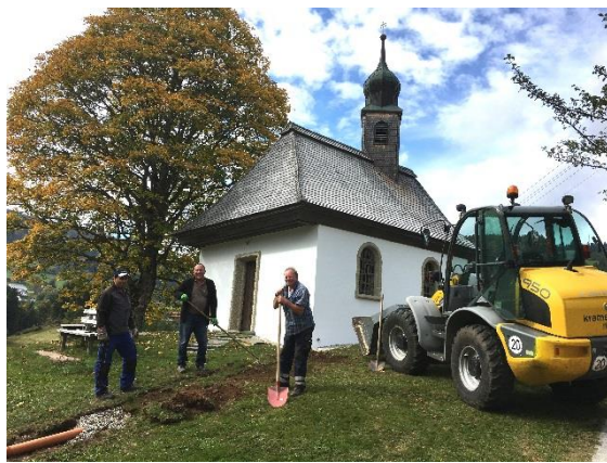
Renovierung der Josefskapelle mit tatkraftiger Unterstützung des Bauhofs
