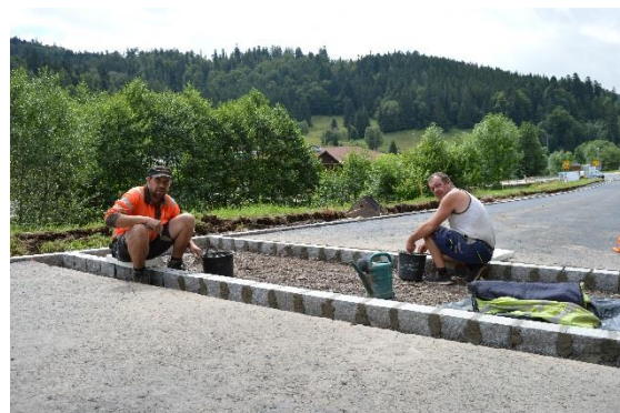
Sanierung Vordertodtmoos – Wehratalstraße, Bauabschnitt I Beginn: 06/2017
