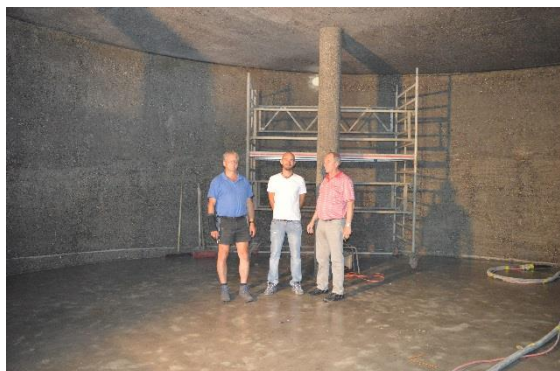
Sanierung Hochbehälter Kälberweid seit 05/2017 unter Regie von Wassermeister Wolfgang Paul
