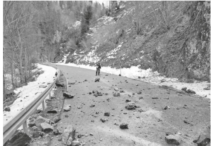
Fotos: Landratsamt Lörrach / Fachbereich Straßen
