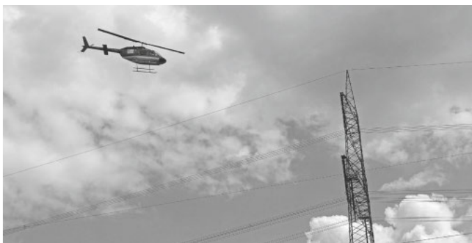
Foto: Amprion GmbH
